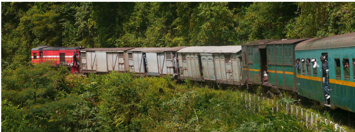
Photo 12 : Train Fianarantsoa-Manakara, infrastructure indispensable mais souvent indisponible, Sud-Est
