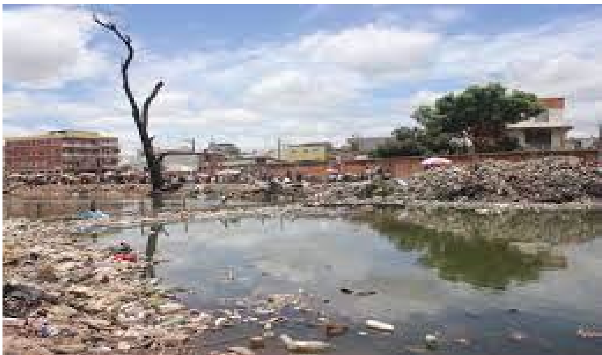
Photo 17 : Canal à ciel ouvert d'évacuation des égouts d'Antananarivo
